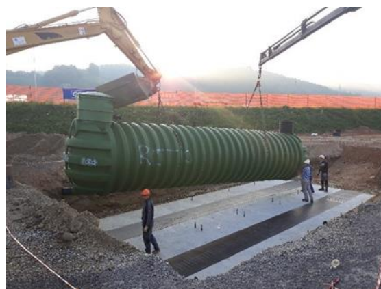
Obr. 4 – Instalace nádrže do stavební jámy
