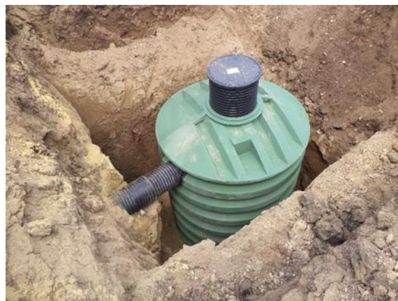
Obr. 6 – Nádrž usazená na svém místě
