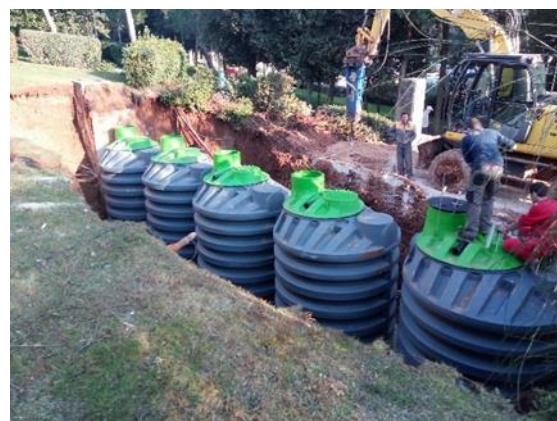
Obr. 5 – Řada vzájemně propojených nádrží
