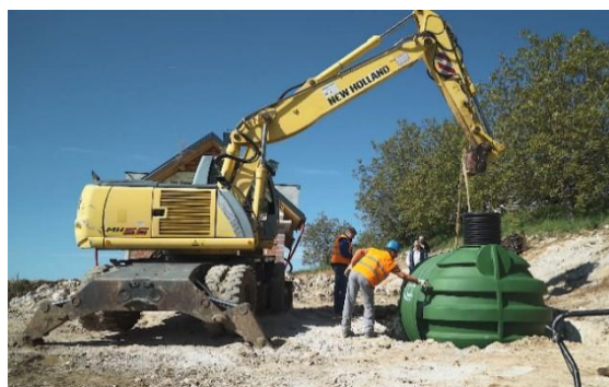
Obr. 3 – Ukládání menší nádrže do stavební jámy
