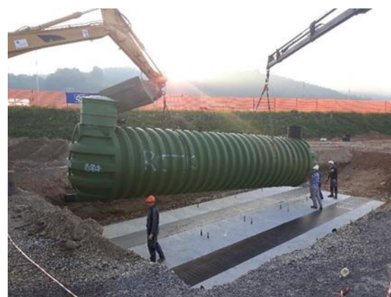
Obr. 4 – Instalace větší nádrže do stavební jámy
